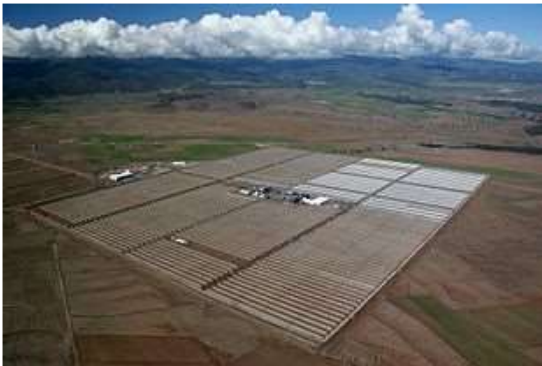
La centrale Andasol
