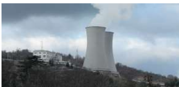
Torri di raffreddamento (foto)
