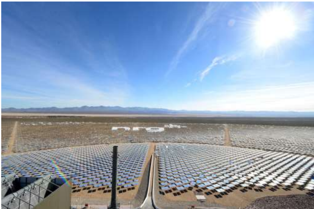
Vista aerea di parte degli eliostati presenti a Ivampah
