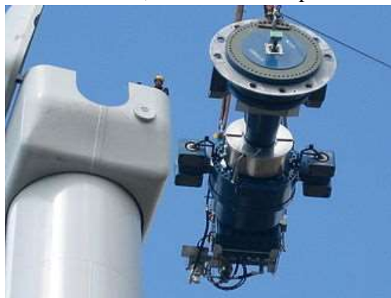
Componenti di una turbina eolica ad asse orizzontale (cambio, albero rotore e freno) vengono posizionati sulla gondola.
