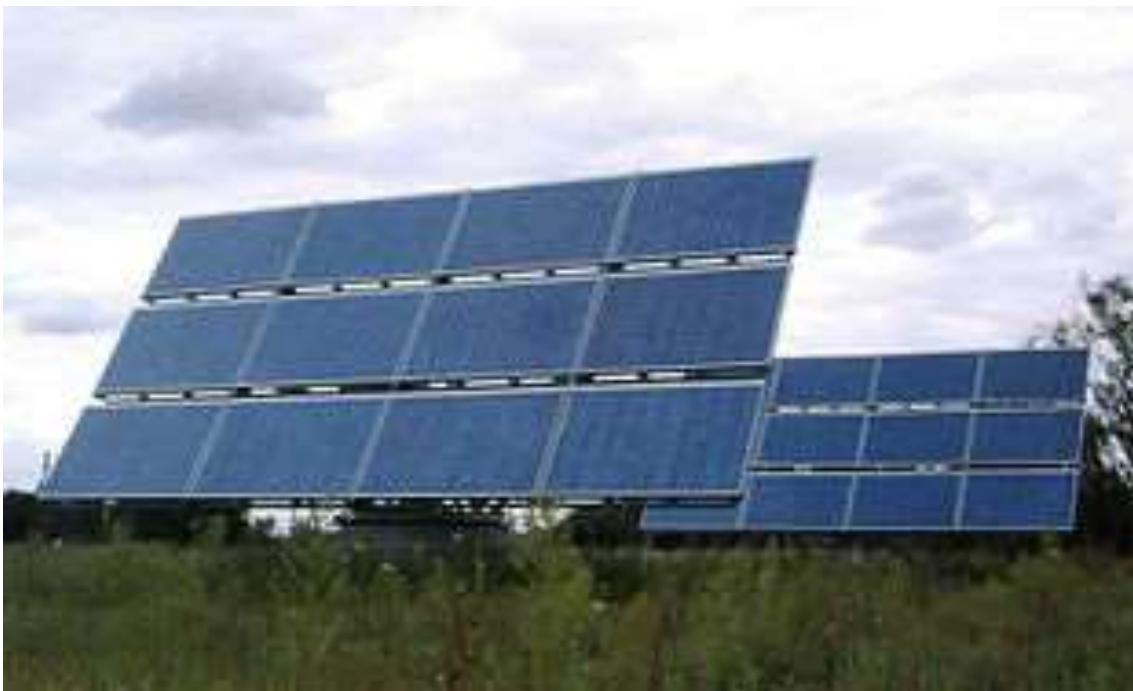
Due pannelli formati ognuno da 12 moduli fotovoltaici montati su supporti a inseguimento solare
