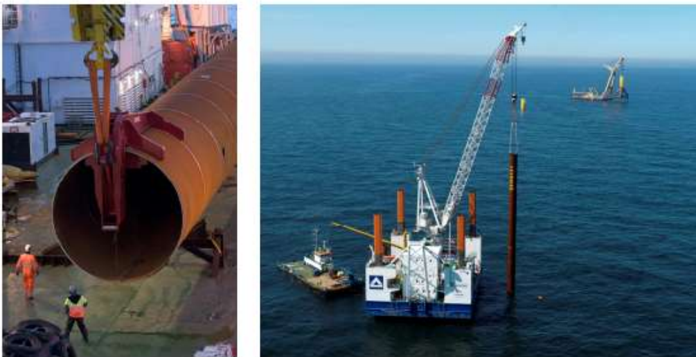
Fondazione a monopalo installata nel Mare del Nord.
