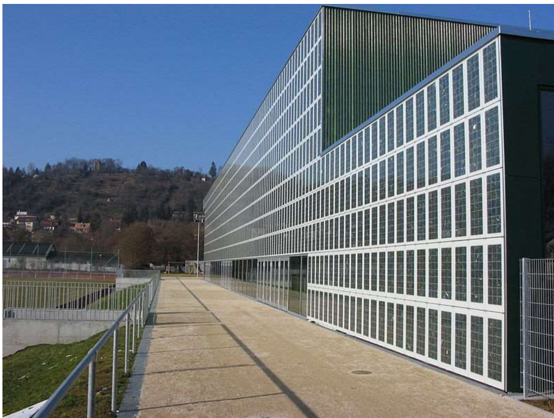
Esempio di parete di palazzetto dello Sport ricoperta di pannelli fotovoltaici: Tubinga.
