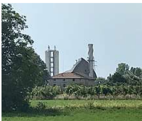
Centrale del teleriscaldamento di Reggio Emilia-Cavazzoli.
