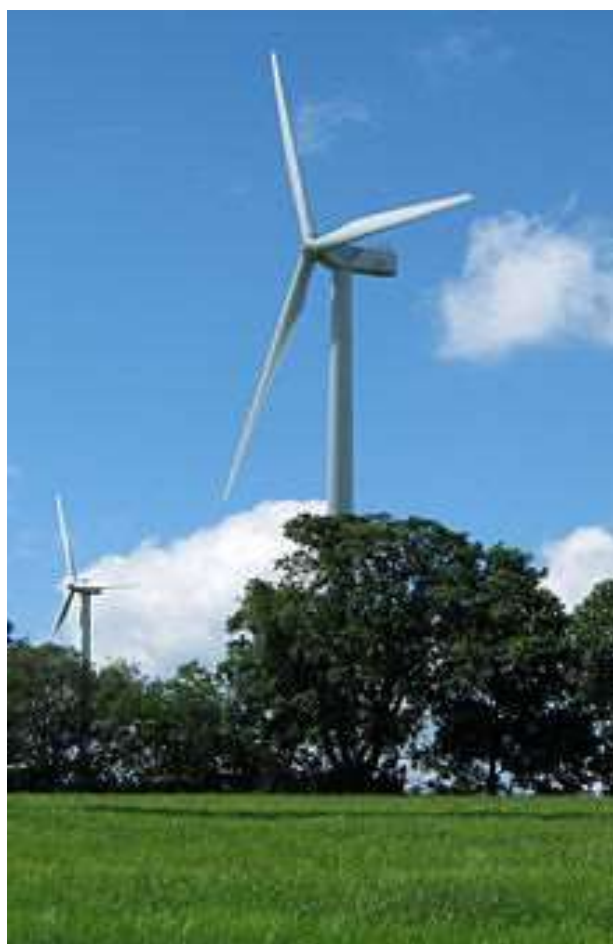
Generatore ad asse orizzontale tripala composto da torre, navicella, rotore e pale
