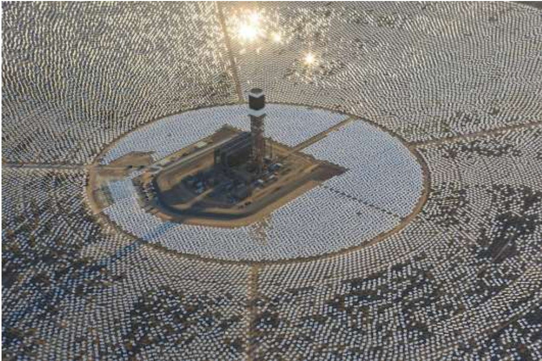
Vista aerea di una porzione della centrale energetica Ivanpah
