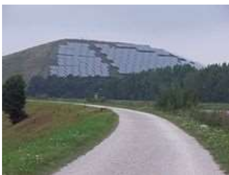
Una centrale fotovoltaica da 500 kWp
