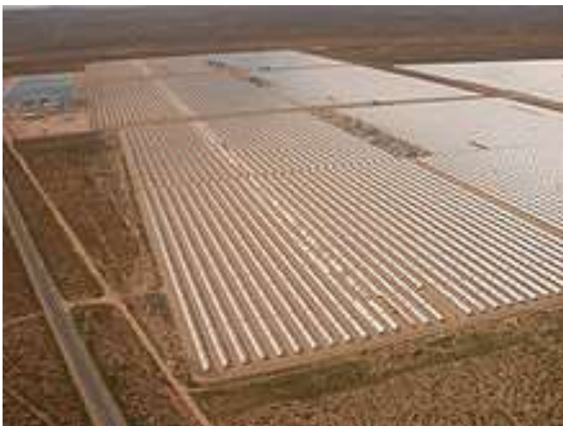
Veduta aerea dei SEGS di Kramer Junction
