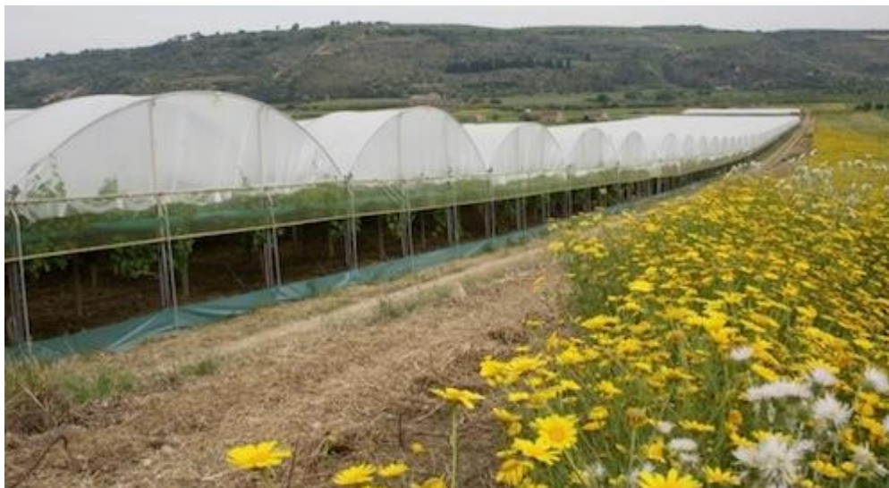
Sicilia, provincia di Catania - Serre con strutture metalliche senza riscaldamento, per la produzione di uva da tavola a maturazione precoce
